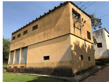
Figura 18. Vista Geral da Casa de Transformadores da captação do Ribeirão Pirai.
