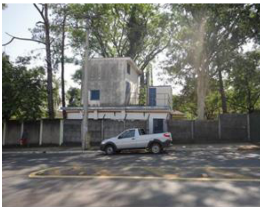
Figura 91. Vista Geral do Booster Estação.
