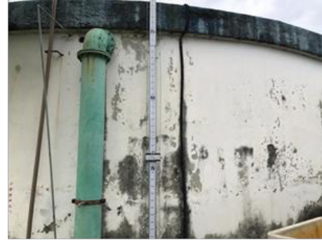
Figura 34. Reservatório Apoiado EAT Nova Era.
