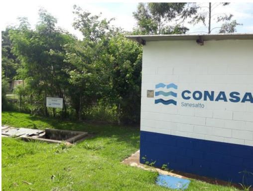
Figura 171. Estação Elevatória de Esgoto – Rondon - Vista 1.
