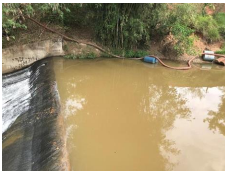
Figura 19. Vista Geral da Captação João Jabour.
