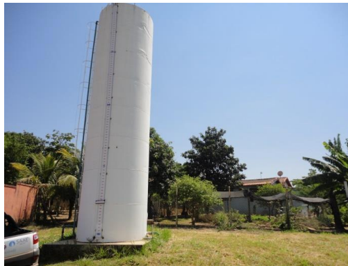
Figura 71. Vista Geral do EAT Santa Isabel e do Reservatório EAT.
