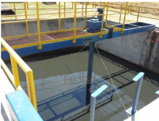
Figura 107. Vista de um dos módulos desarenadores.
