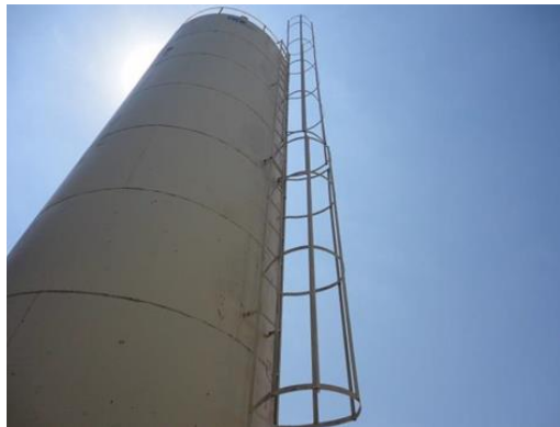
Figura 68. Reservatório Elevado Novo EAT Buru
