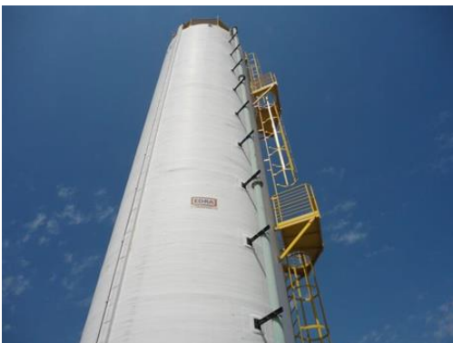
Figura 74. Reservatório Elevado EAT Portal dos Bandeirantes.
