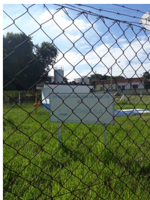
Figura 163. Estação Elevatória de Esgoto – 03 - Vista 1.
