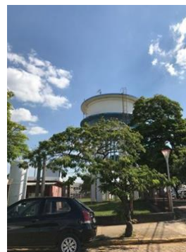
Figura 29. Reservatório Elevado – EAT Hospital.
