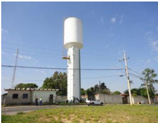
Figura 57. Vista Geral do EAT João Jabour.
