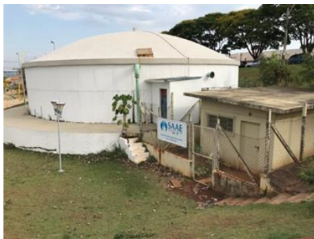
Figura 28. Reservatório Apoiado – EAT Hospital.
