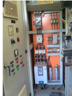
Figura 170. Estação Elevatória de Esgoto – Final - Vista 4.
