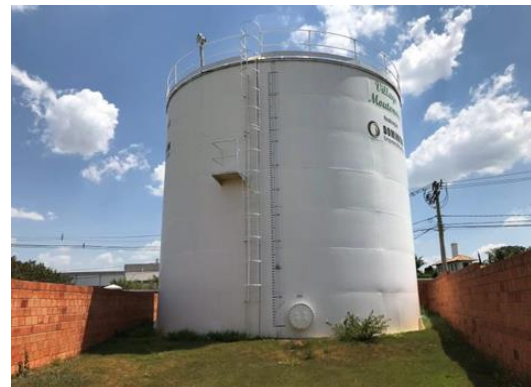
Figura 77. Reservatório Apoiado EAT Moutonnée.
