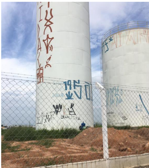
Figura 86. Visão Geral dos Reservatórios EAT Imperial
