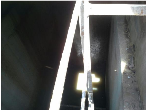
Figura 169. Estação Elevatória de Esgoto – Final - Vista 3.
