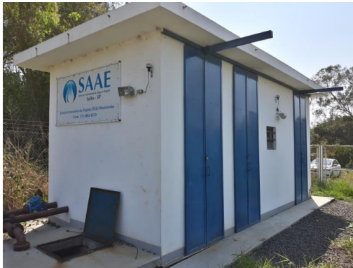
Figura 137. Estação Elevatória de Esgoto – Moutonné - Vista 1.
