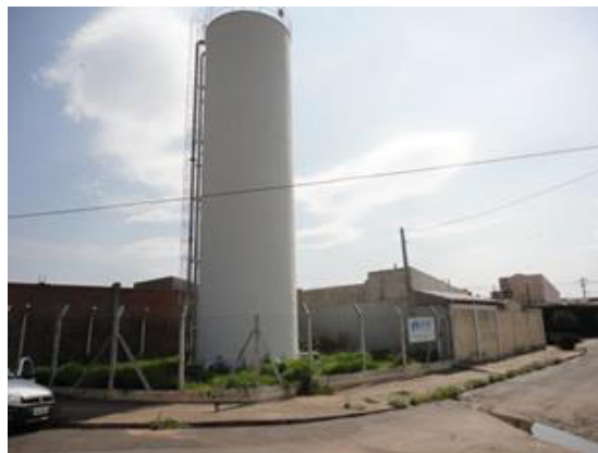
Figura 61. Vista do Reservatório Elevado EAT Santa Marta.
