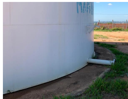
Figura 85. Visão geral do Reservatório EAT Taquaral
