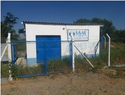
Figura 118. Estação Elevatória – Santa Efigênia.
