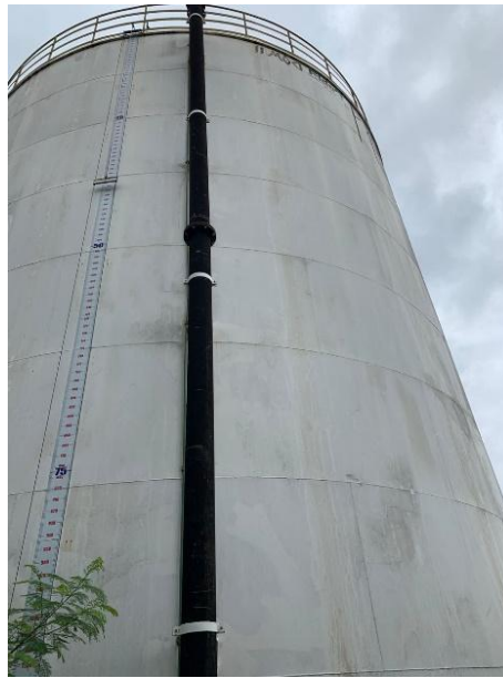
Figura 32. Reservatório Metálico – EAT Hospital.
