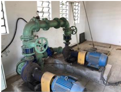
Figura 47. Conjuntos motor - bomba do EAT SAAE.
