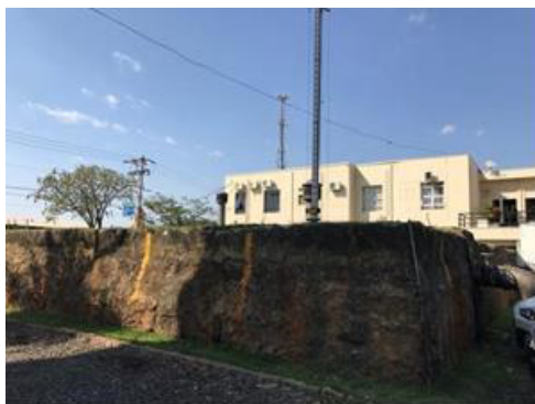
Figura 45. Reservatório Apoiado – EAT SAAE.
