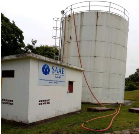
Figura 81. Visão Geral do Reservatório do Moradas São Luís 1
