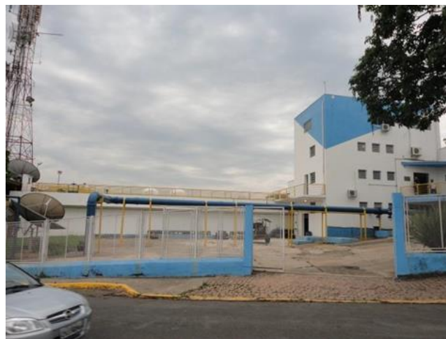
Figura 26. Vista Geral da ETA Bela Vista.
