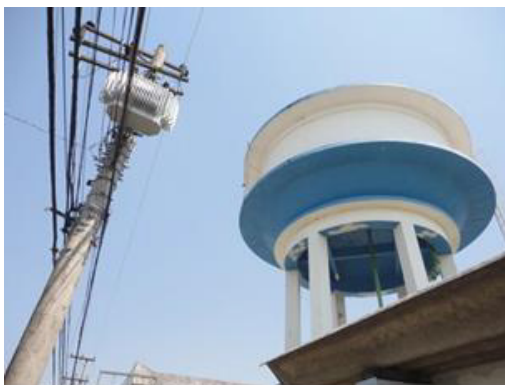
Figura 43. Reservatório Elevado EAT Jardim Cidade (Siemens).
