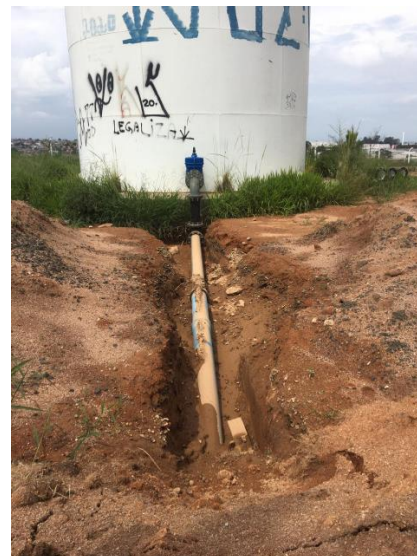
Figura 87. Passagem de tubulação EAT Imperial
