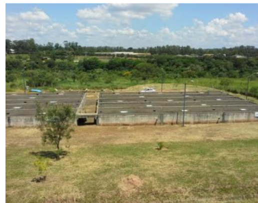
Figura 112. Vista do sistema de Biofiltros.
