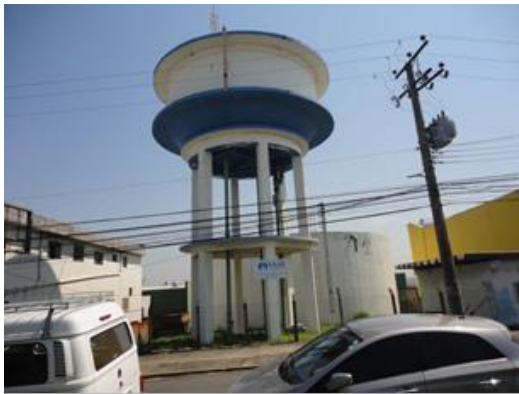
Figura 41. Vista Geral do EAT Jardim Cidade (Siemens).
