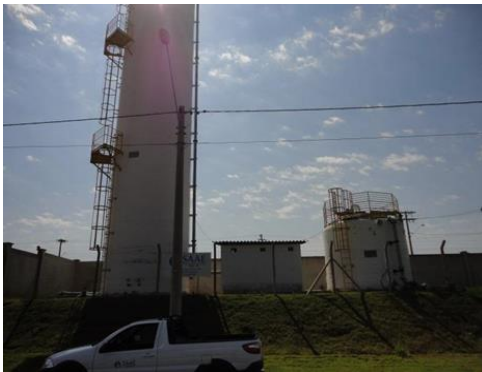
Figura 72. Vista Geral do EAT Portal dos Bandeirantes.
