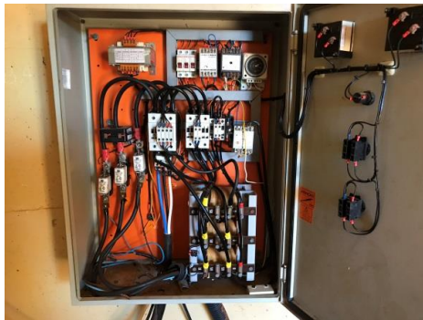
Figura 133. Estação Elevatória de Esgoto – Vila Martins - Vista 3.
