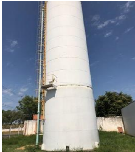
Figura 80. Vista Geral do Reservatório Elevado do EAT Madre Paulina.
