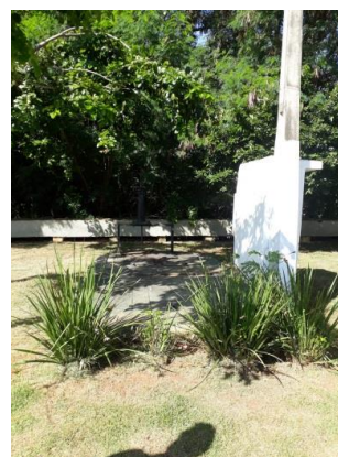
Figura 160. Estação Elevatória de Esgoto – 02 - Vista 2.
