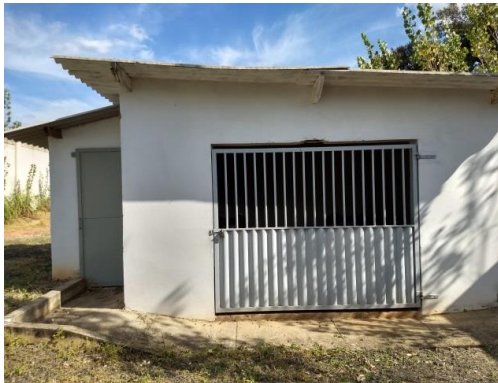
Figura 135. Estação Elevatória de Esgoto – Portal dos Bandeirantes - Vista 1.
