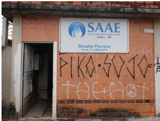
Figura 95. Vista Geral do Booster Floriano.
