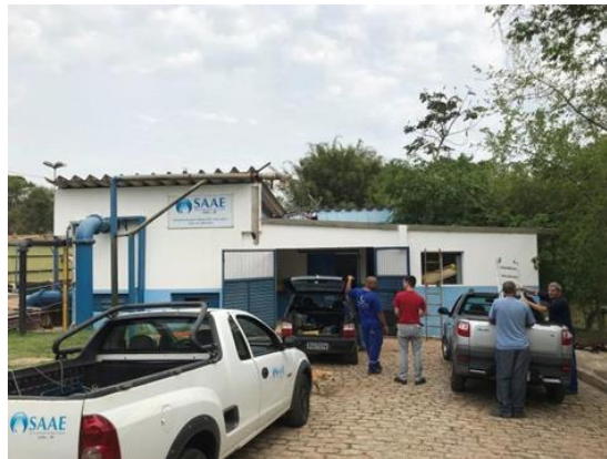
Figura 27. Vista geral da ETA João Jabour.
