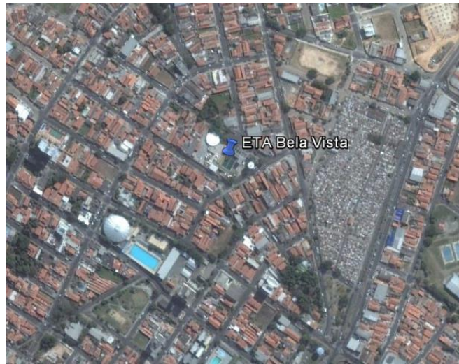
Figura 25. Posição relativa da ETA - Bela Vista no município de Salto.
