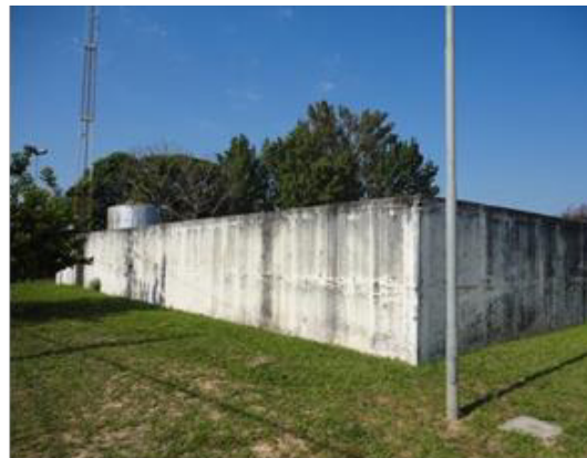
Figura 58. Reservatório Semienterrado EAT João Jabour.
