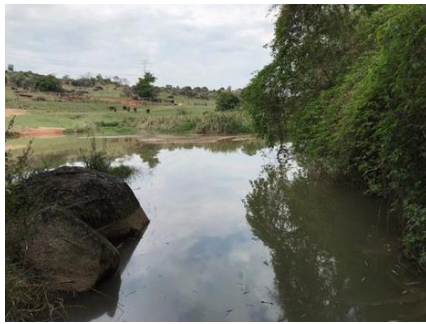
Figura 21. Vista Geral da Captação Conceição.
