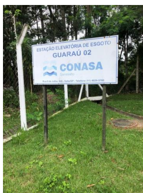
Figura 151. Estação Elevatória de Esgoto – Guarau II - Vista 1.
