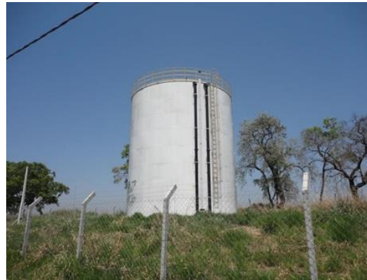
Figura 79. Reservatório Apoiado EAT Vila Martins.
