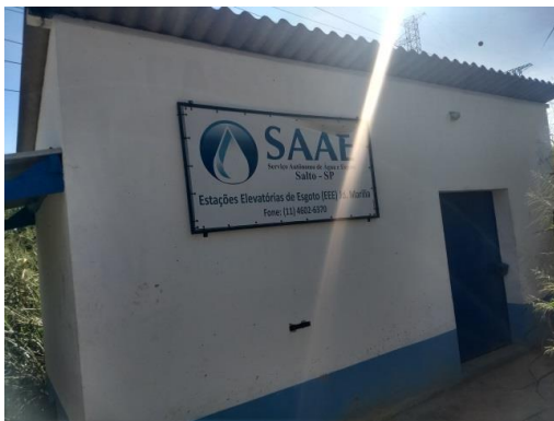
Figura 116. Estação Elevatória Jardim Marília.
