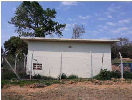
Figura 131. Estação Elevatória de Esgoto – Vila Martins - Vista 1.
