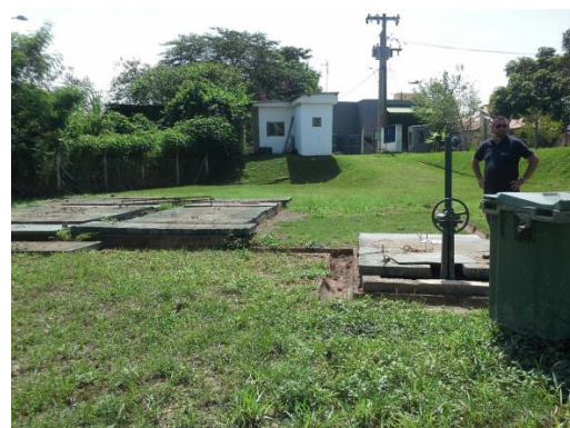
Figura 168. Estação Elevatória de Esgoto – Final - Vista 2.
