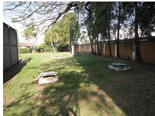
Figura 54. Reservatório Enterrado EAT Haras Paineiras.
