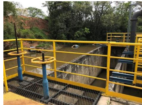
Figura 20. Vista Geral da Captação João Jabour.
