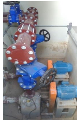
Figura 134. Estação Elevatória de Esgoto – Vila Martins - Vista 4.
