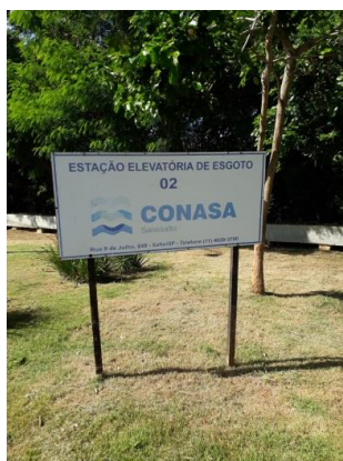
Figura 159. Estação Elevatória de Esgoto – 02 - Vista 1.
