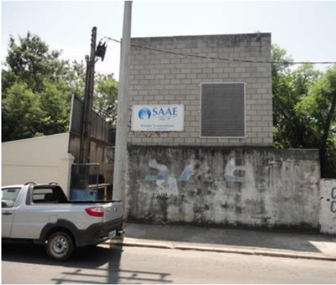
Figura 93. Vista Geral do Booster dos Trabalhadores.
