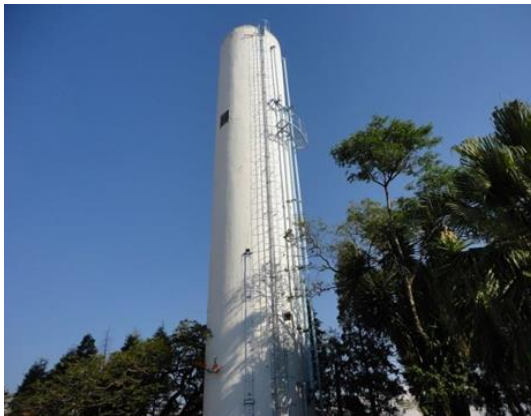
Figura 55. Reservatório Elevado EAT Haras Paineiras.
