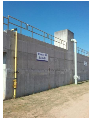
Figura 110. Vista do Reator Anaeróbio.
