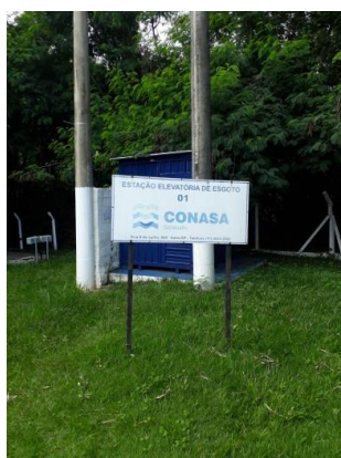
Figura 155. Estação Elevatória de Esgoto – 01 - Vista 1.
