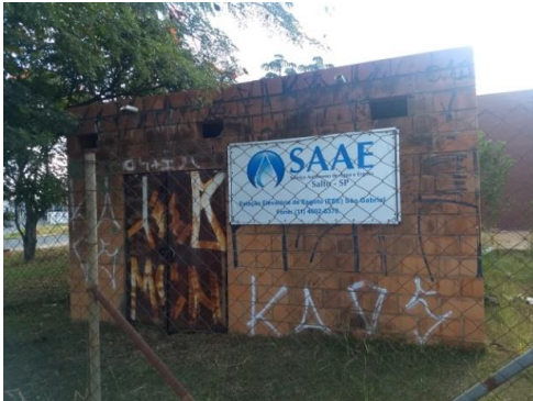
Figura 124. Estação Elevatória de Esgoto – São Gabriel – Vista 1.
