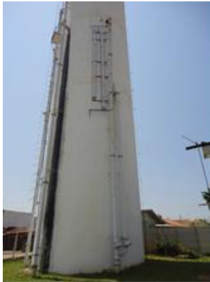
Figura 39. Reservatório Elevado EAT Santa Cruz.
