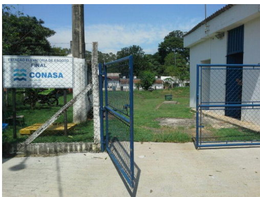
Figura 167. Estação Elevatória de Esgoto – Final - Vista 1.
