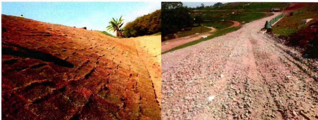
Figuras 49 e 50- Plantio De Grama No Talude E Estrada De Acesso À Área De Aterramento
