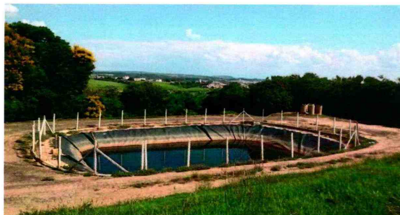
Figura 52- Reservatório De Líquidos Percolados Nº 2
