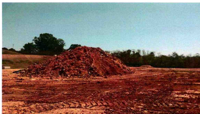
Figura 57- Depósito De Terra Para Cobertura Diária
