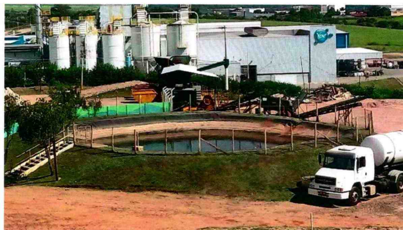
Figura 51 - Reservatório De Líquidos Percolados Nº 1
