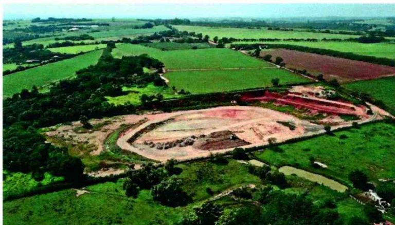
Figura 16 - Aterro de Inertes Chapada, 2019
