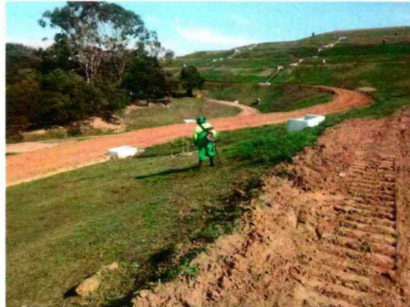
Figura 59- Roçada Mecanizada Para Manutenção Dos Taludes
