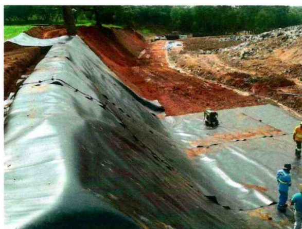
Figura 58 - Obra De Impermeabilização Com Geomembrana PEAD
