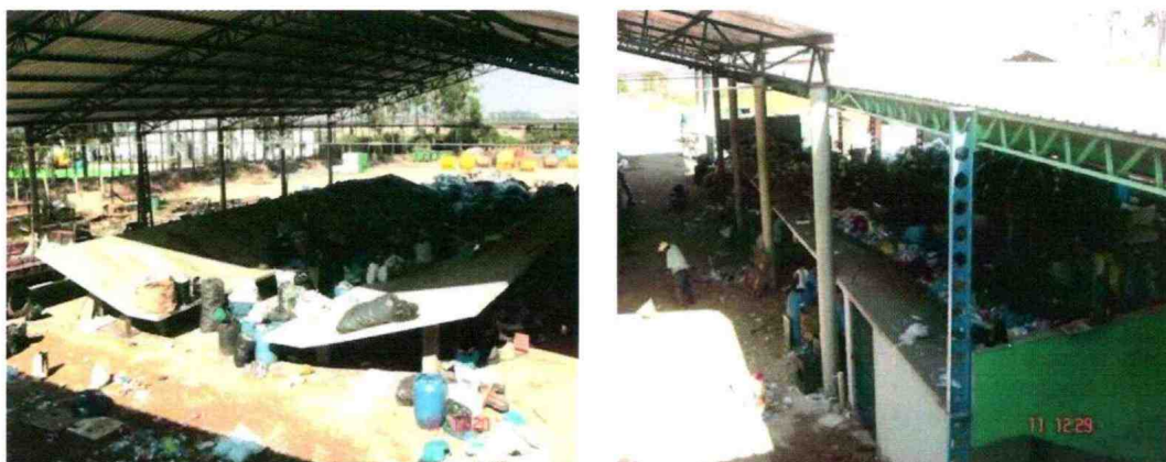
Figura 46 - Galpão De Triagem
